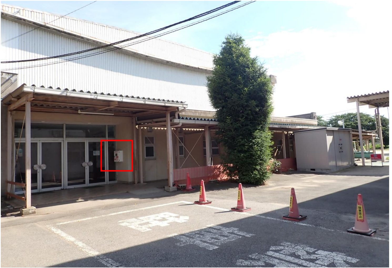
西部小学校（設置場所：体育館入口脇壁面）
