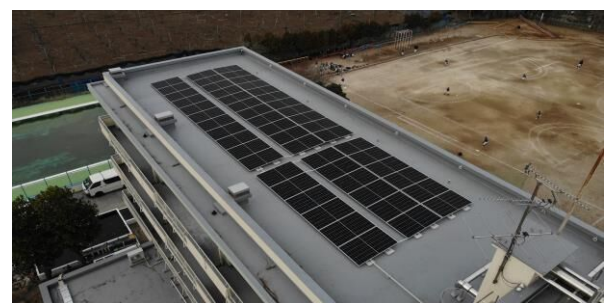
道野辺小学校の校舎屋上へ太陽光パネルを設置
