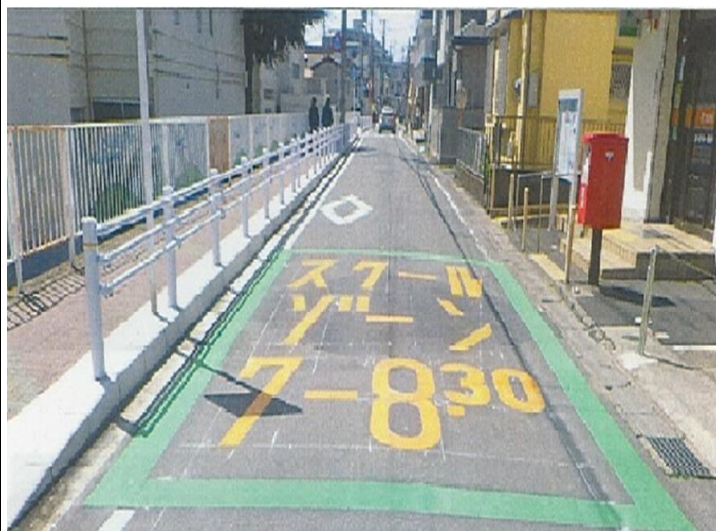
「鎌ケ谷小学校正門前に設置した防護柵」
