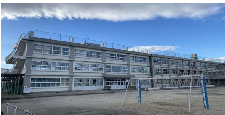
東部小学校校舎外壁・屋上防水改修工事
