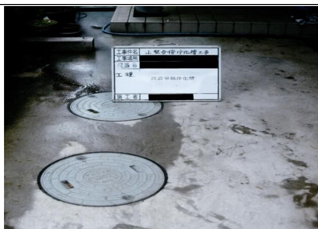
19. 既設単独処理浄化槽又は くみ取り便槽の全景
