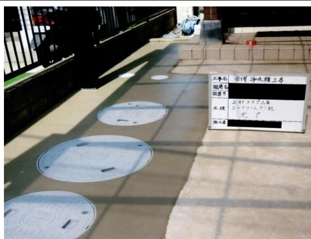
18. 合併処理浄化槽完了後
