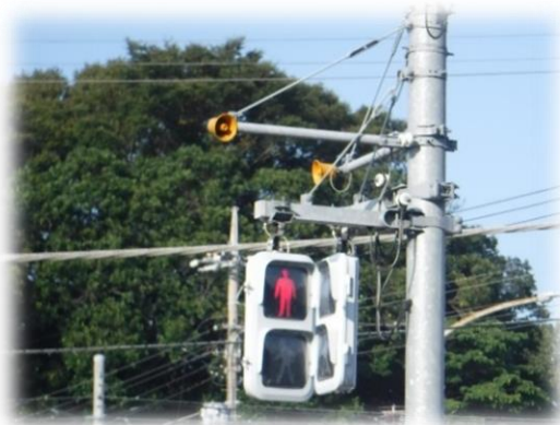
音響装置付信号機の設置 （市道24号線）
