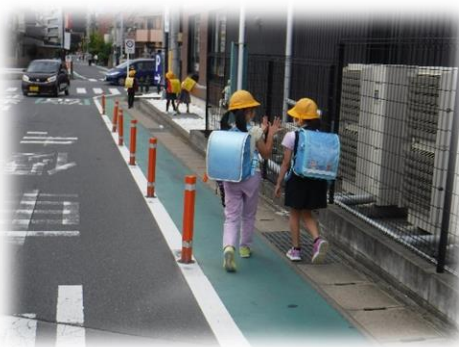
車線分離標（市道2334号線）
