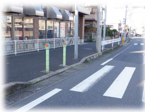
車止め（鋼製）（市道 3 7 号線）
