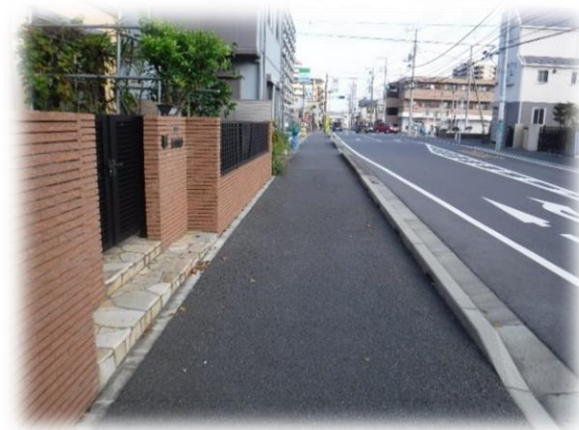
市道 22 号線 整備状況
