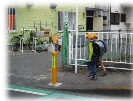
車止め（鋼製）（市道2339号線）
