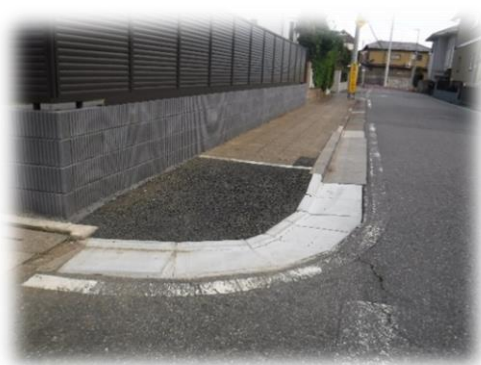
歩道段差解消切り下げ工事 (市道2766号線)
