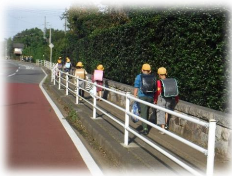
防護柵（市道12号線）
