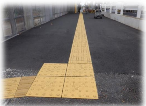
視覚障がい者誘導用ブロック （市道44号線）
