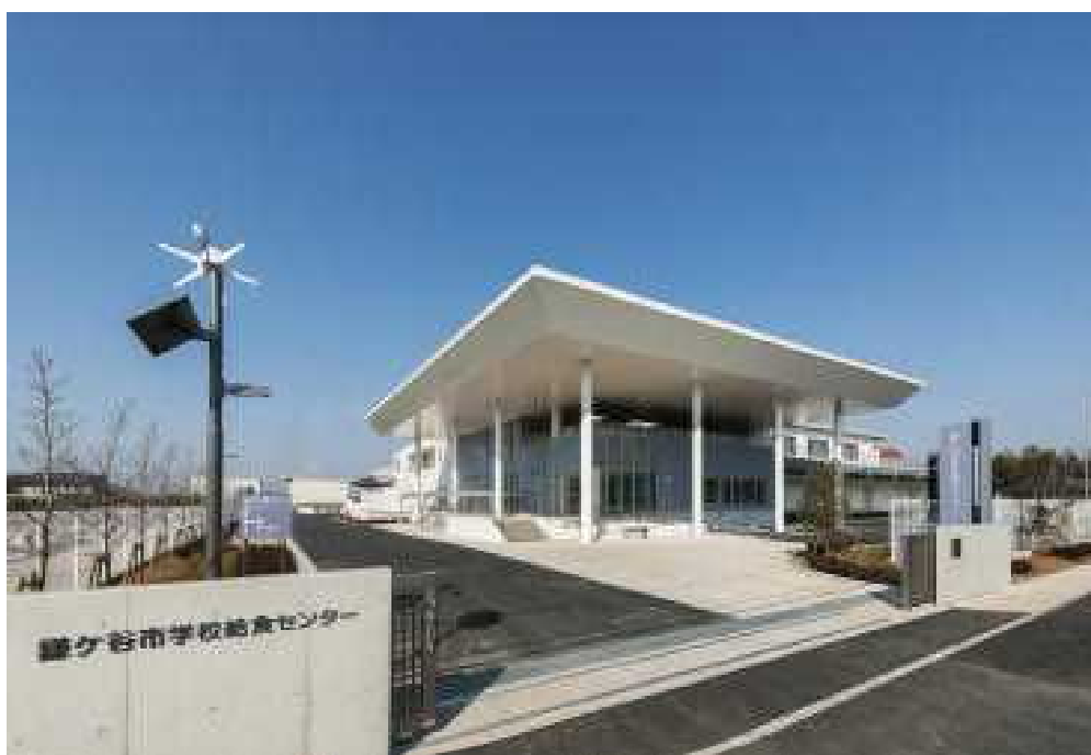
鎌ヶ谷市学校給食センター
