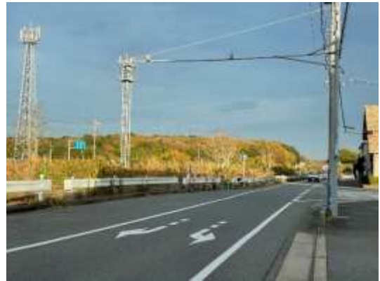
指定緊急輸送道路（国道464号）
