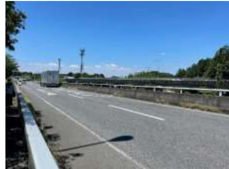
指定緊急輸送道路（国道 464 号）
