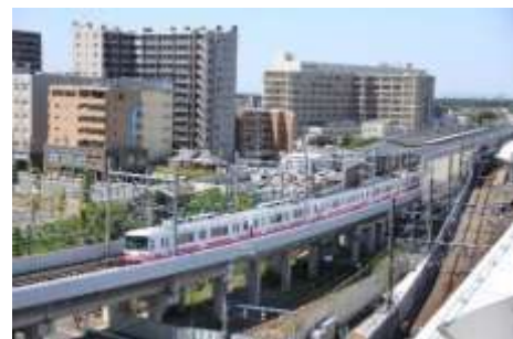
新京成線連続立体交差事業
