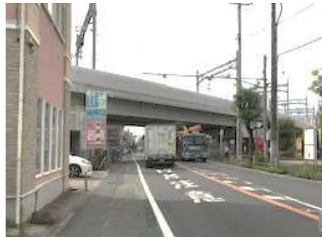
連続立体交差事業による 道路状況の改善
