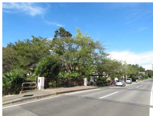
■大津川&lt;一級河川&gt;に架かる山王橋
