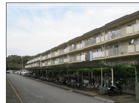
■住宅団地(東鎌ヶ谷)
