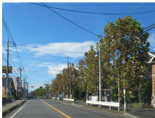
■主要地方道千葉鎌ヶ谷松戸線
