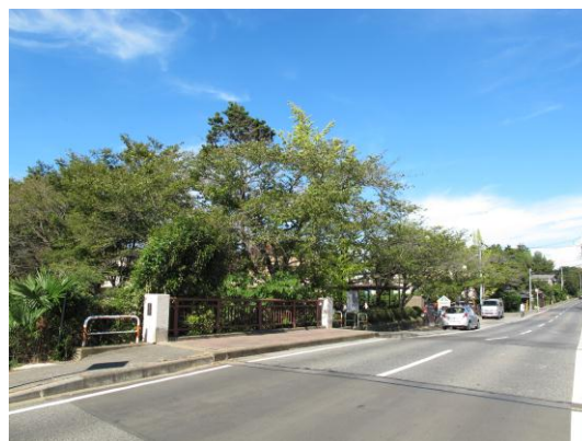
■大津川<一級河川>に架かる山王橋
