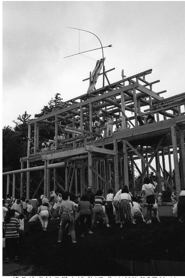
菊名茂家新母屋上棟式(平成1(1989)年7月29日)
